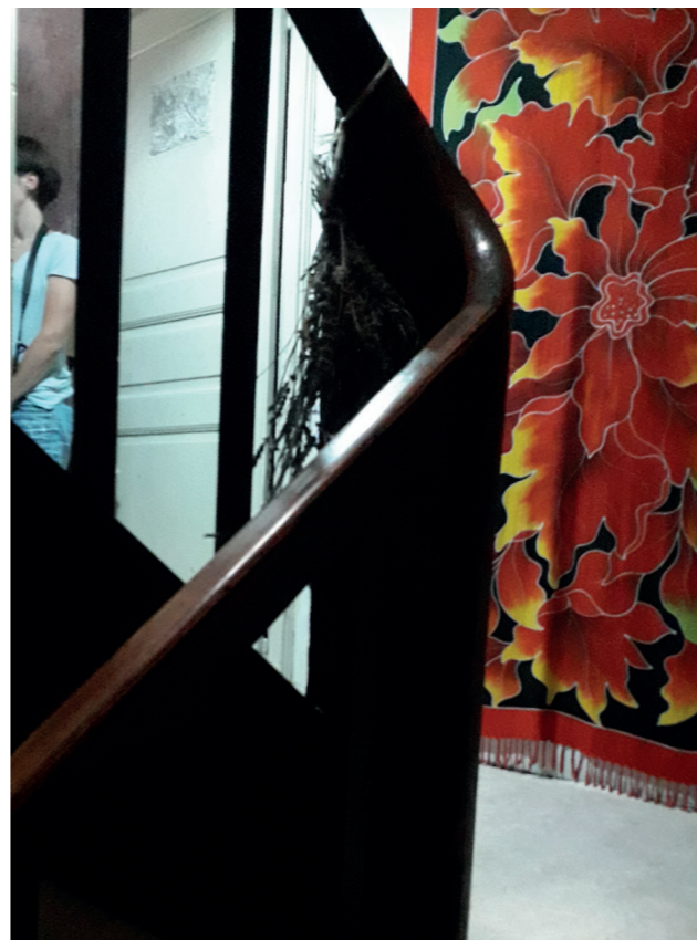
Détail d'escalier : pièce tournante en bois plein
